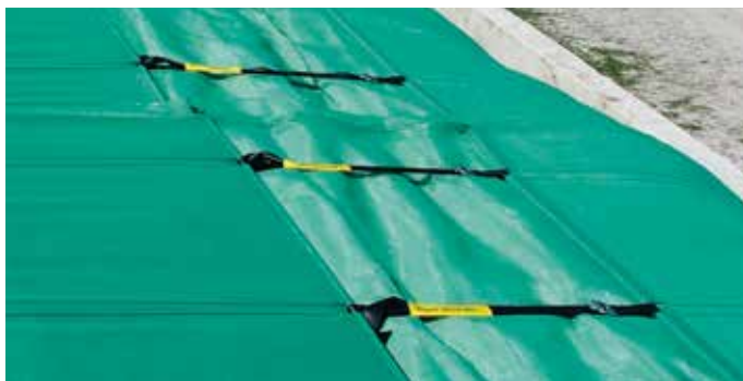
Nový systém zakrytí siláže – rychlá realizace
